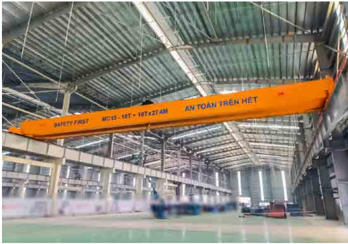
KHU LIÊN HỢP SẢN XUẤT VÀ LẮP ĐẶT KIM LONG MOTOR
