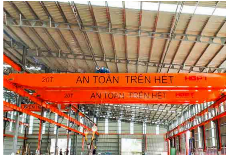
NHÀ MÁY GIA CÔNG CƠ KHÍ HGPT MỞ RỘNG
